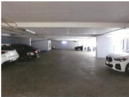
19. สภาพภายในอาคาร (ชั้นที่ 1)
