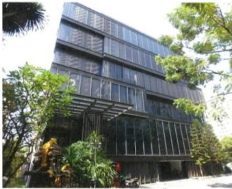
14. อาคารสำนักงานสูง 6 ชั้น
